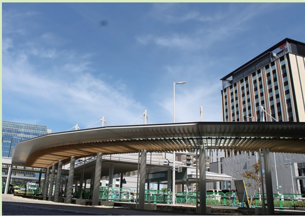
図 2 不燃集成材を使用した例（金沢駅西口シェルターの軒天）。参考 加賀木材㈱ホームページ https://kagamoku.com/works/ より
